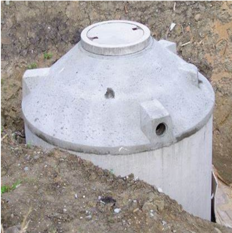
Zisterne im Aufbau
